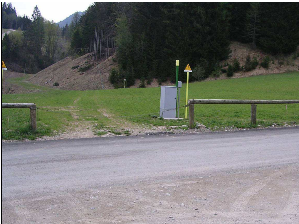
Fig. 6.6 - I cartelli segnalatori del metanodotto ed i tubi di sfiato posti in corrispondenza degli attraversamenti eseguiti con tubo di protezione.
