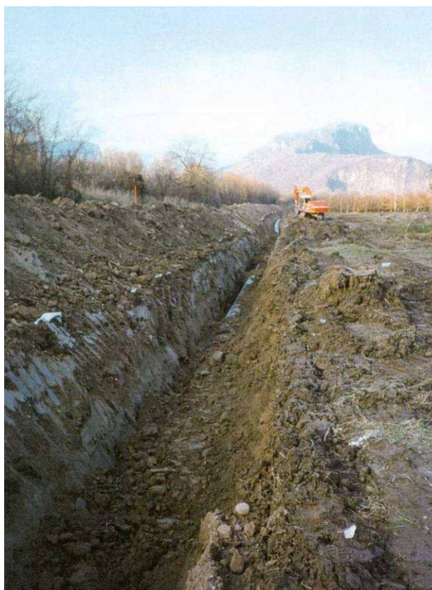
Fig. 6.3 - Operazione di rinterro della condotta.
