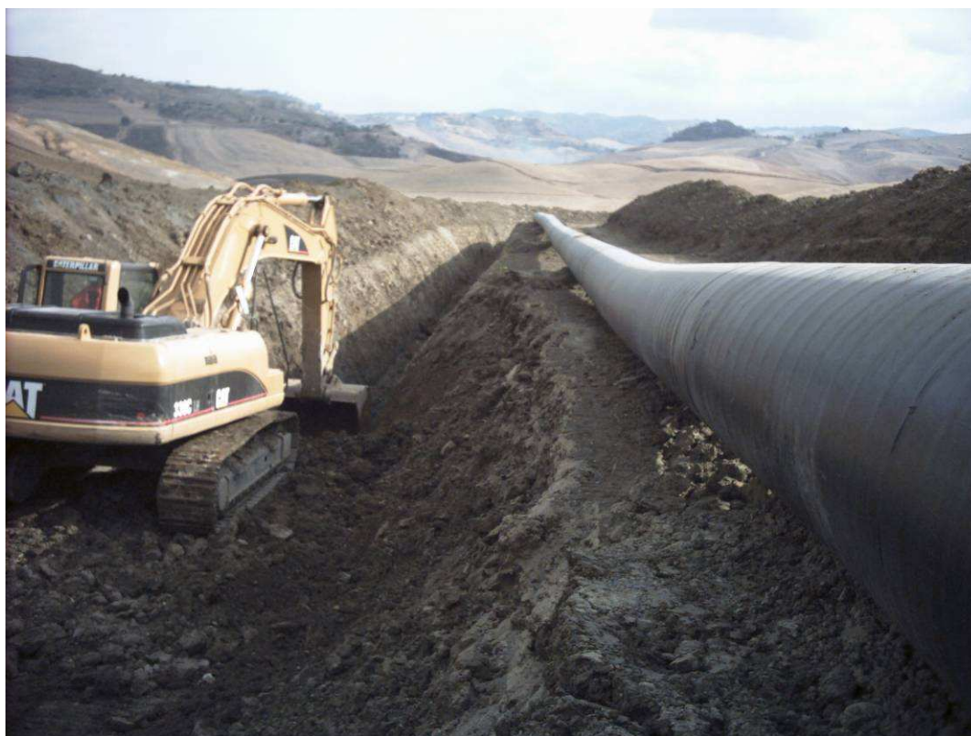
Fig. 6.2 - Scavo per l'alloggiamento della condotta.
